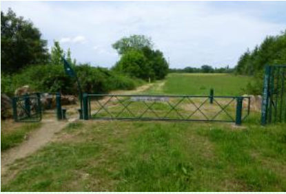
Ensemble de barrières à Etiolles, espace des Coudrays (91)
