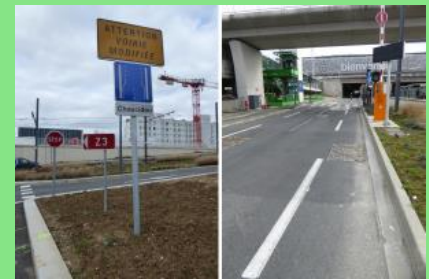
Plus de piste, passage par route de service ADP (en CCVB), mars 2015
